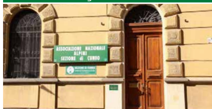
Ingresso attuale della Sezione
